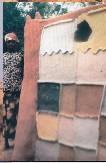
Revestimento de reboco enriquecido com estabilizante, Tâmmoun, Saara argelino.
